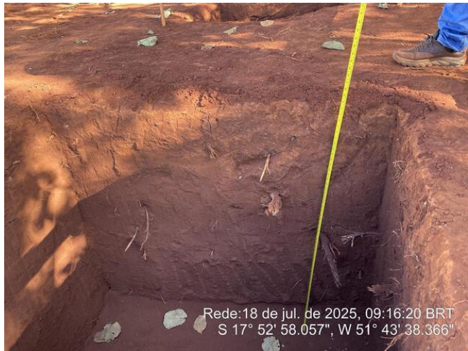
Escavação da sapata
