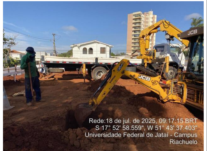
Escavação da sapata
