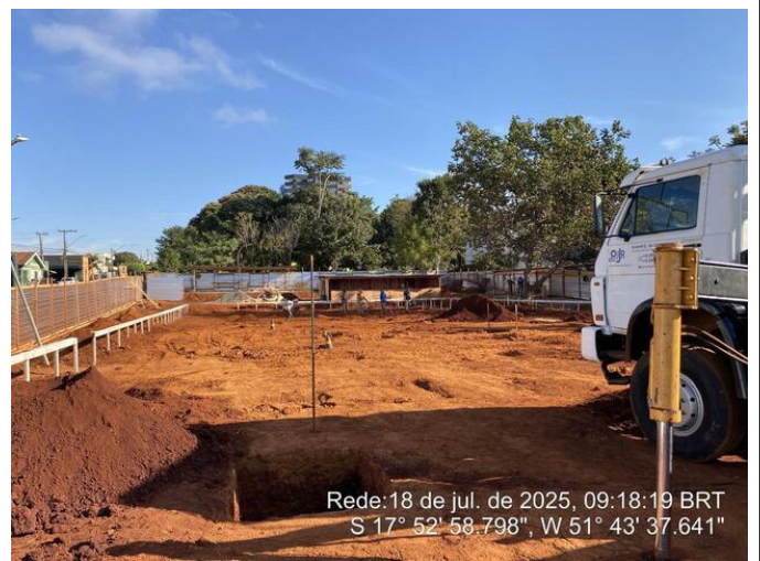
Escavação da sapata
