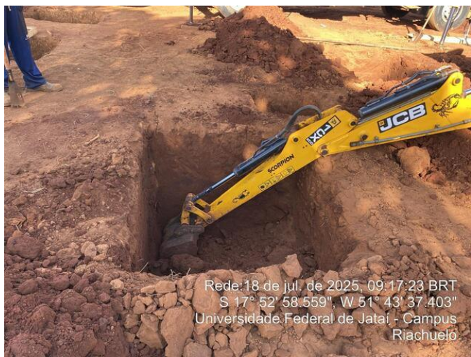
Escavação da sapata
