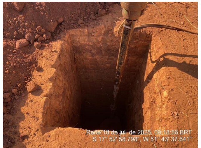
Escavação da sapata
