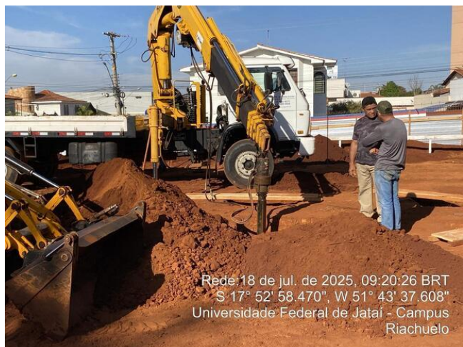
Escavação da sapata
